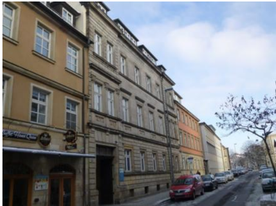
Abbildung 12: Gebäude im Urzustand an der R.-W.-Straße (Nr. 33)
