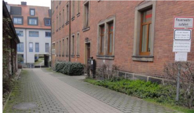
Abbildung 75: fehlende Zuwegung zum Logenhaus von der Richard-Wagner-Straße
