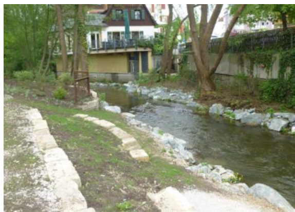
Abbildung 78: Zugang zum Mühlkanal (Mai 2016)
