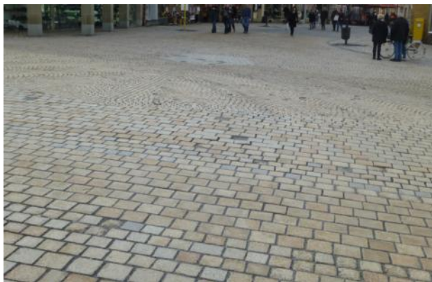
Abbildung 47: Typische Natursteinpflasterung (Sternplatz)
