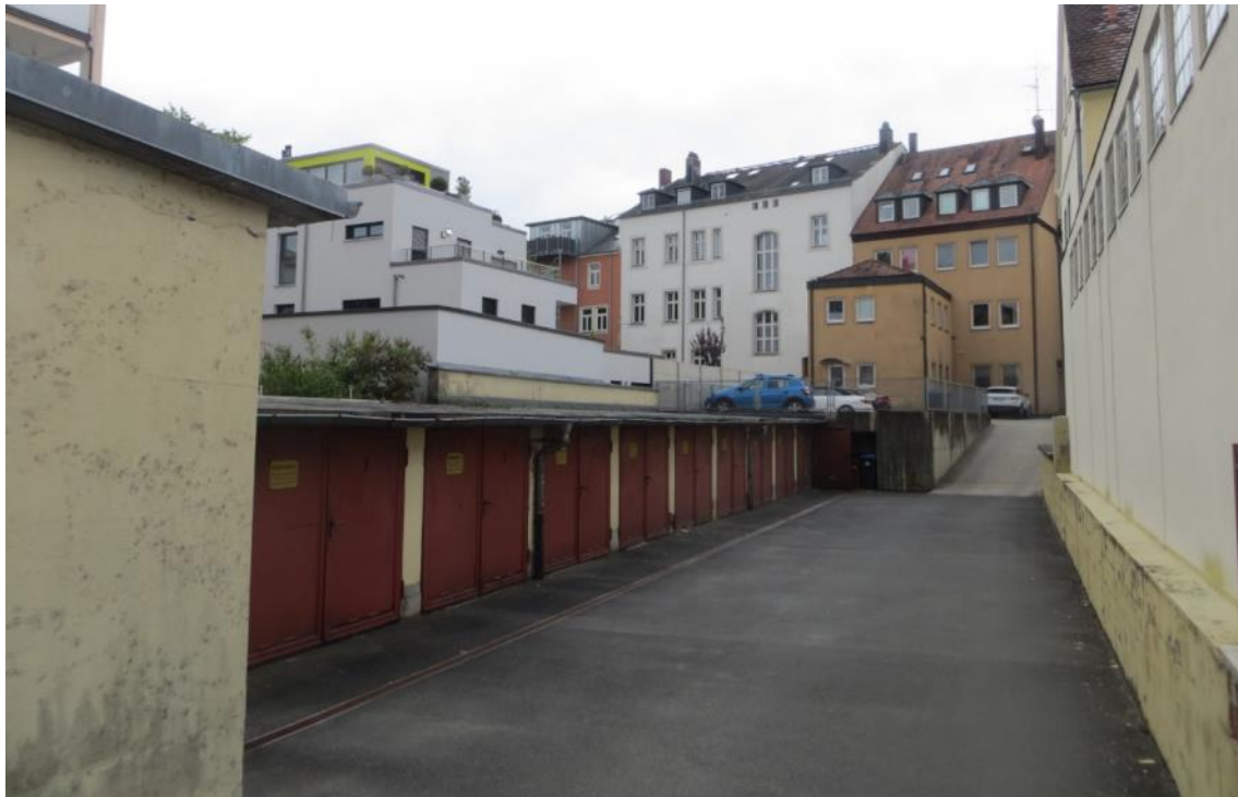
Abbildung 65: Diffuse Gestaltung und fehlende Raumkante (gegenüber Werner-Siemens-Straße 5-9)
