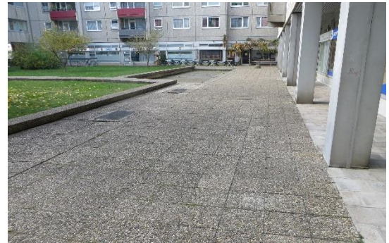
Abbildung 67: Blockinnenbereich des Ring-Hochhauses
